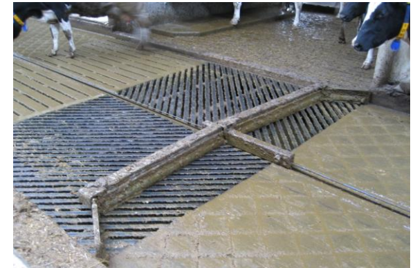
RIST I KVÆGSTALD, SOM SKRABEREN PASSERER SÅ DEN FLYDENDE DEL KAN ADSKILLES FRA DEN FASTE. BILLEDE FRA HTTP://LVM.DK/ .
