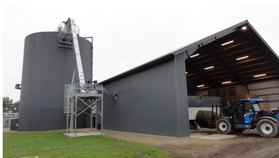
PÅ AU FOULUMS BIOGASANLÆG LÆSSES RUNDBALLER MED FORTØRRET ENGGGRÆS OP I BIO-MIKSEREN, SOM DEREFTER FØDER DET OVER I EKSTRUDEREN, HVORFRA DET FØDES IND I FORGÆRINGSTANKEN. UD OVER LÆSNINGEN, REGULERES PROCESSEN AUTOMATISK.
