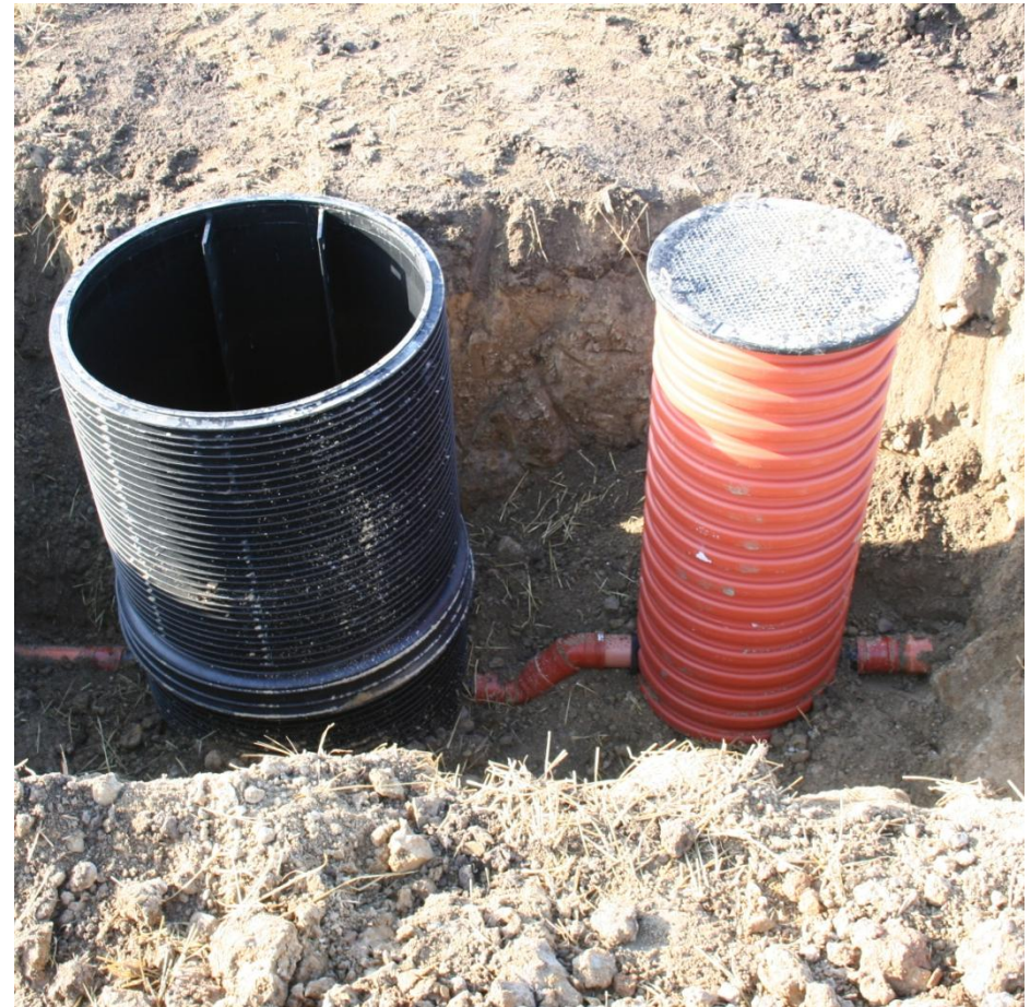
EN MÅLEBRØND OG EN REGULERINGSBRØND UNDER ETABLERING PÅ HOFMANGAVE.
